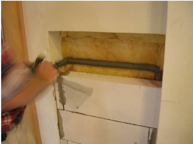
werden. Im Oktober 2011 wurden im Erdgeschoss (kleiner und großer Saal) die als Kältebrücken identifizierten Heizungsrisen gedämmt und geschlossen und die Heizkörper inkl. Thermostatventile ausgetauscht.
