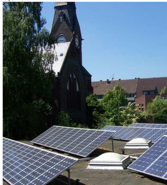
Die monatlich erzeugte Strommenge wurde ab August 2010 monatlich erfasst und soll zukünftig im Rahmen des Umweltmanagements des Grünen Hahn überprüft werden. Es wird mit einer jährlichen Stromerzeugung von 3800 kWh gerechnet.
